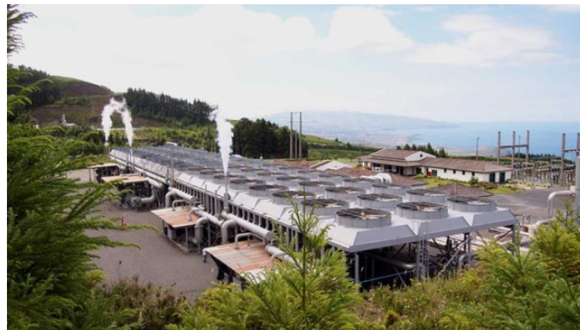
Central Geotérmica da Ribeira Grande 5 MW (1994) + 8 MW (1998)
