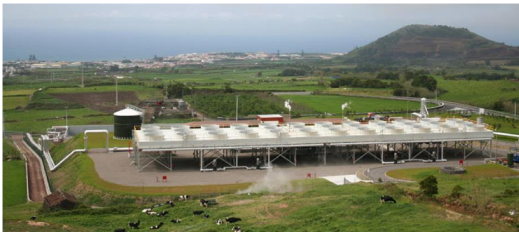
Central Geotérmica de Pico Vermelho 10 MW (2007)
